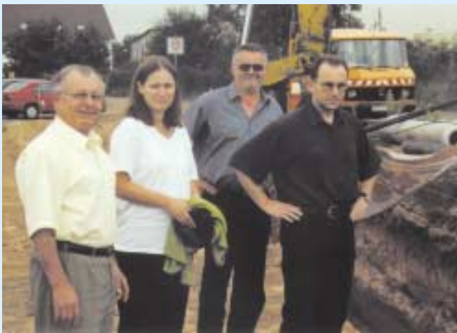
MIT RIESENSCHRITTEN gehen die Erschließungsarbeiten für das Neubaugebiet „Auf dem Felsen II“ in Kirkel-Limbach voran. Davon konnten sich dieser Tage Bürgermeister Arno Hussong und Bauamtsleiter Friedrich Leibrock überzeugen. Die beiden Erschließungsabschnitte zusammen betreffen 17,5 Hektar, der zweite Teil allein 8,5 Hektar mit 95 Wohnbauplätzen. Nur entlang der Bahnstrecke ist ein Mischgebiet ausgewiesen mit fünf Bauplätzen. Auf unserem Bild von links nach rechts: Bürgermeister Arno Hussong, Dipl.-Ing. Sabine Knecht, Bauamtsleiter Friedrich Leibrock, Dipl.-Ing. Jürgen Heintz.
