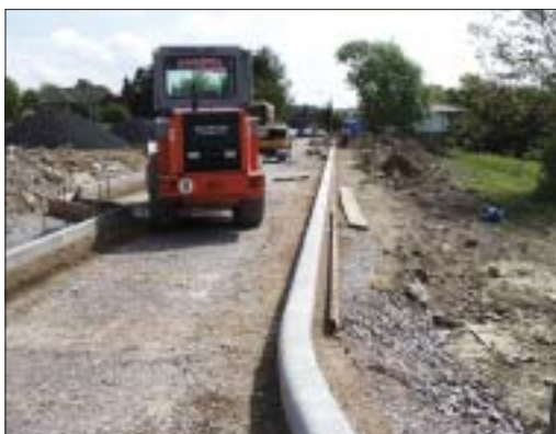
Foto: Bauarbeiten an der Flurstraße im vollen Gange
