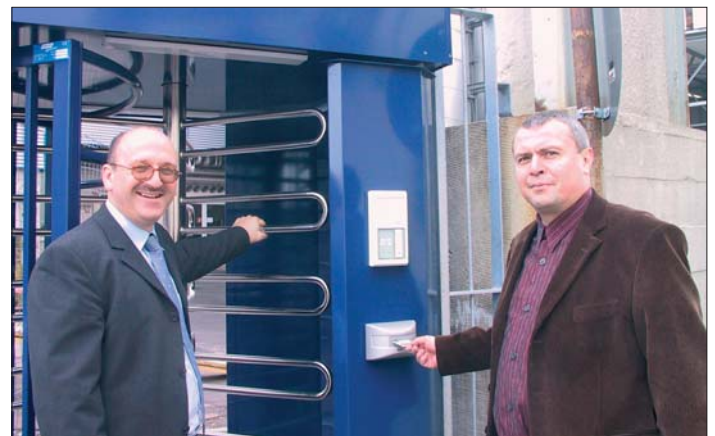
Foto: Walle Geschäftsführer Manfred Schilling und (rechts) Andreas Kayser, Leiter der Bauabteilung von Karlsberg, demonstrieren das neue Zugangssystem zum Lagergebäude.
