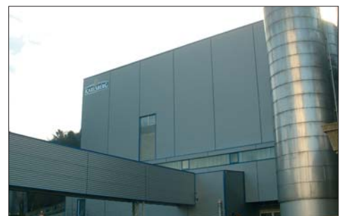
Foto: Nach der Sanierung.
