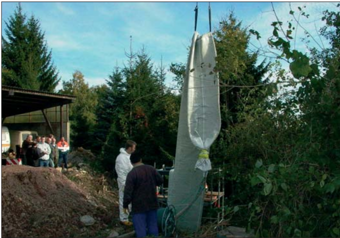
Foto: Einbau eines „Inliners“ zur Kanalsanierung in Heckendahlheim.
