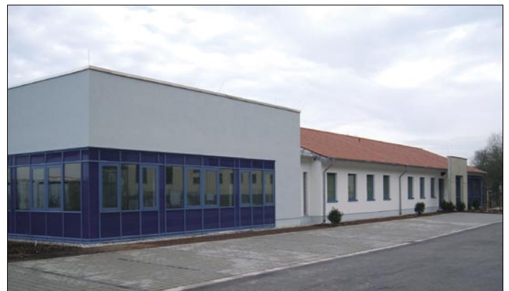
Gesamtansicht des fertiggestellten Bauhofes in Blieskastel.
