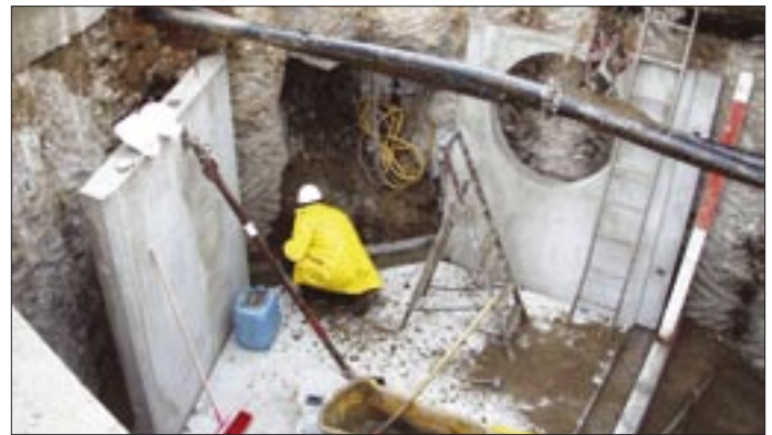
Foto: Arbeiten an der Bohrfahrlwand des Abwassersammlers in Wittersheim. Die Fertigteilwände des Pumpwerkes in der Saargemünder Straße werden montiert.
