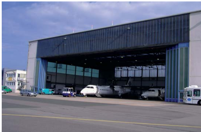
Die Werfthalle am Saarbrücker Flughafen vor der Neugestaltung.
