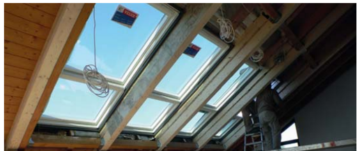
Bei der Sanierung von Häusern wird eine zusätzliche Wärmedämmung eingebaut.
