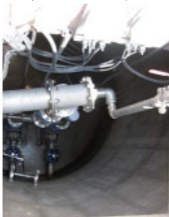
Blick in eines der beiden neuen Regenwasserrückhaltebecken.
