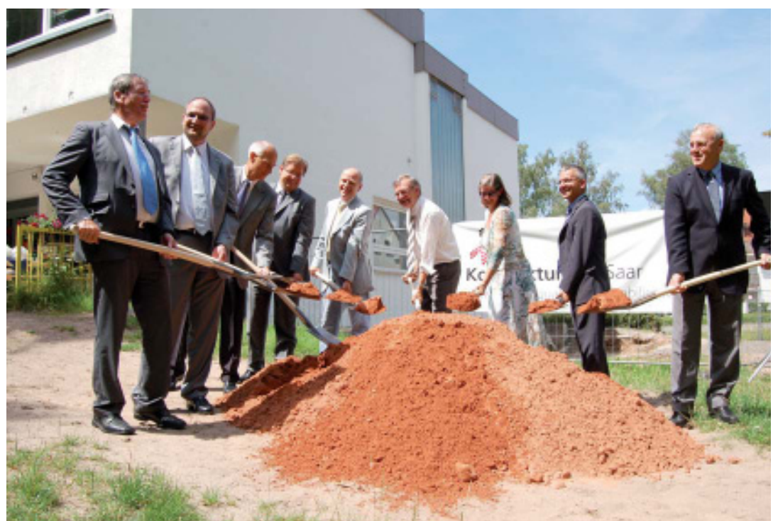
Die hochrangige Besetzung beim Spatenstich für den Um- und Neubau symbolisiert die Wichtigkeit der Baumaßnahmen.
