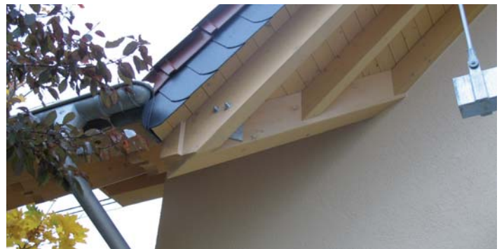
Fachmännisches Handwerk überzeugte bei der Sanierung und dem Ausbau des Daches.
