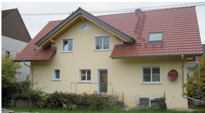
Die Wärmedämmung spart erheblich an Kosten.
