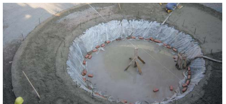
Die runde Form spart Platz und ermöglicht die weitestgehende Selbstreinigung des Beckens.
