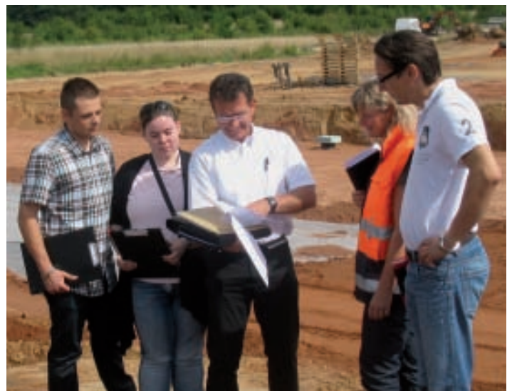
Nicolas Bieg, Kristina Stein, Rainer Walle mit Ingrid Hector (ZEK Kleinblittersdorf) und Helge Maurer (Bodengutachter GCG-Heer) bei einer Baustellenbesichtigung.
