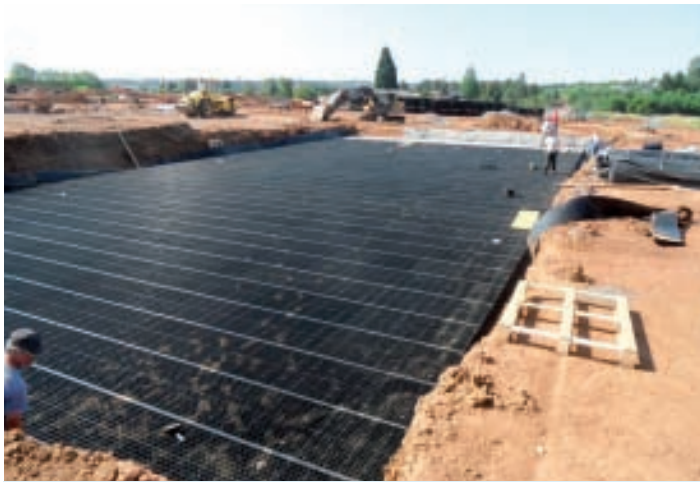
Auf diesen Regenrückhaltetanks entsteht einer der Parkplätze.
