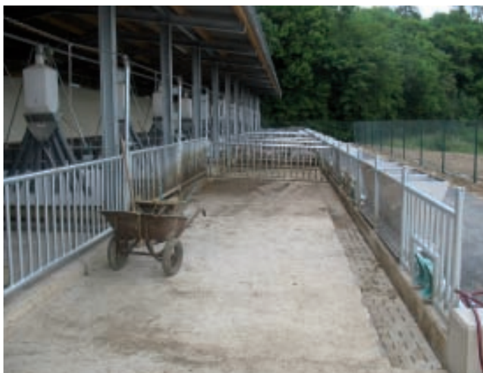
Der Wetterbereich kann mit dem Traktor gereinigt werden.
