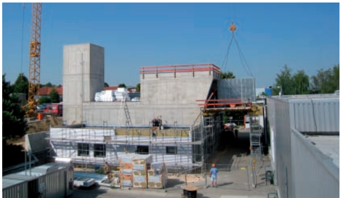
Die Baustelle des Triebwerksprüfstandes der Lufthansatechnik AERO.
