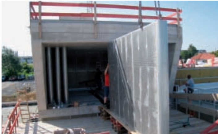
Das Einbringen der erforderlichen Schall-Kulissen zur Geräuschdämmung.
