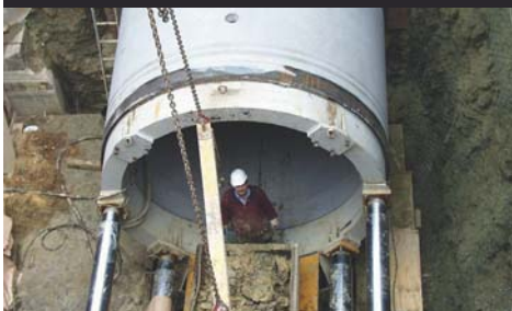
Neubau Hauptsammler Ormesheim, Staukanal, Regenwasserbehandlung
