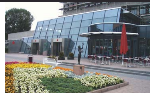
Umbau, Neubau der Kreissparkasse Saarpfalz
