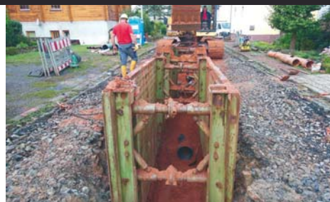
Straßen- und Kanalerneuerung Dekan-Diehl-Straße
