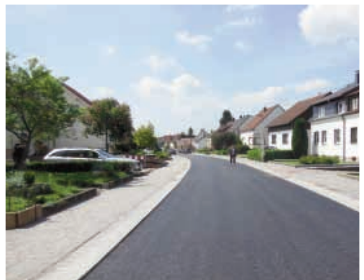
Die Ketteler Straße nach der Sanierung des Kanals.
